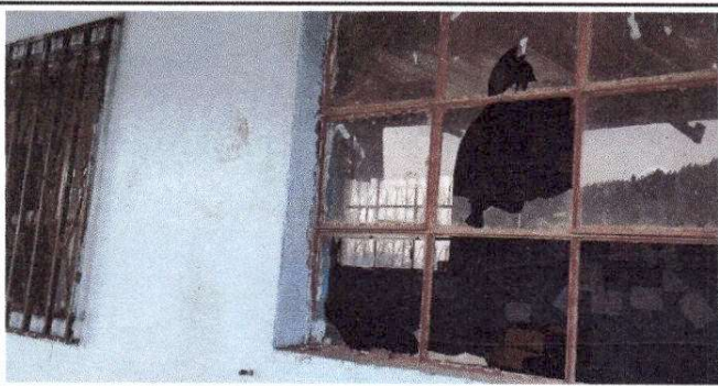
Foto 5: Sustitución de vidrios
