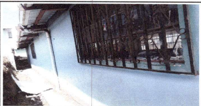
Foto 6: Sustitución de balcones de metal
