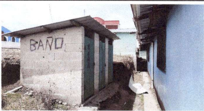
Foto 3: Sustitución en puertas de servicios sanitarios
