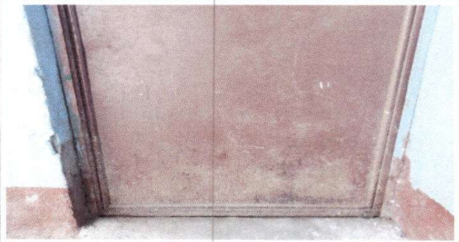
Foto 2: Sustitución de puertas
