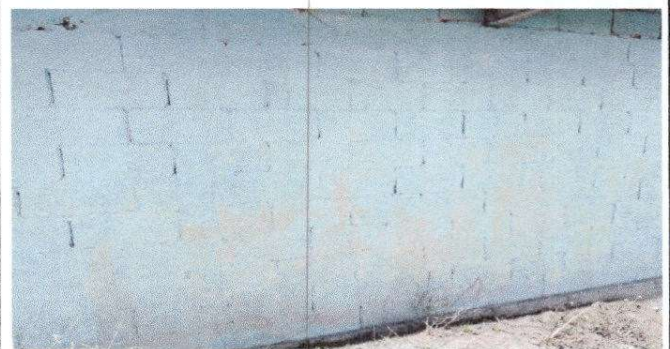
Foto 8: Pintura en muros exteriores e interiores
